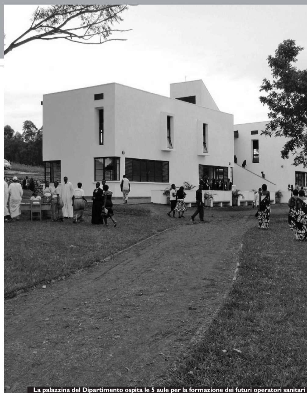
La palazzina del Dipartimento ospita le 5 aule per la formazione dei futuri operatori sanitari
